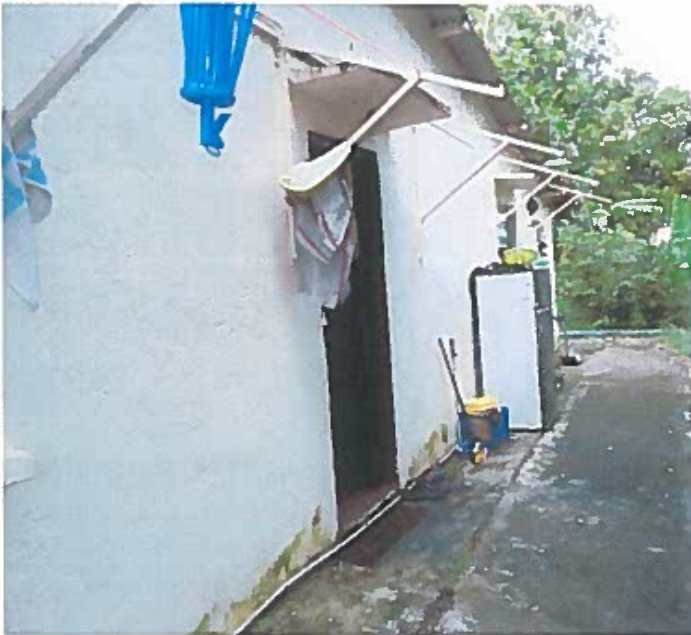
Façade principale du logement
